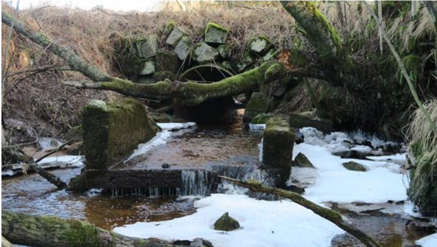
Bild 1. Vägtrumman vid Hästehagen. Betongkonstruktionen nedanför trumman är från gamla vägbron.
