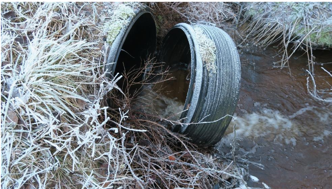
Bild 13. Bäck från Bredmossen. Utloppet från vägtrumma under väg mot Liane och Lianekasen.
