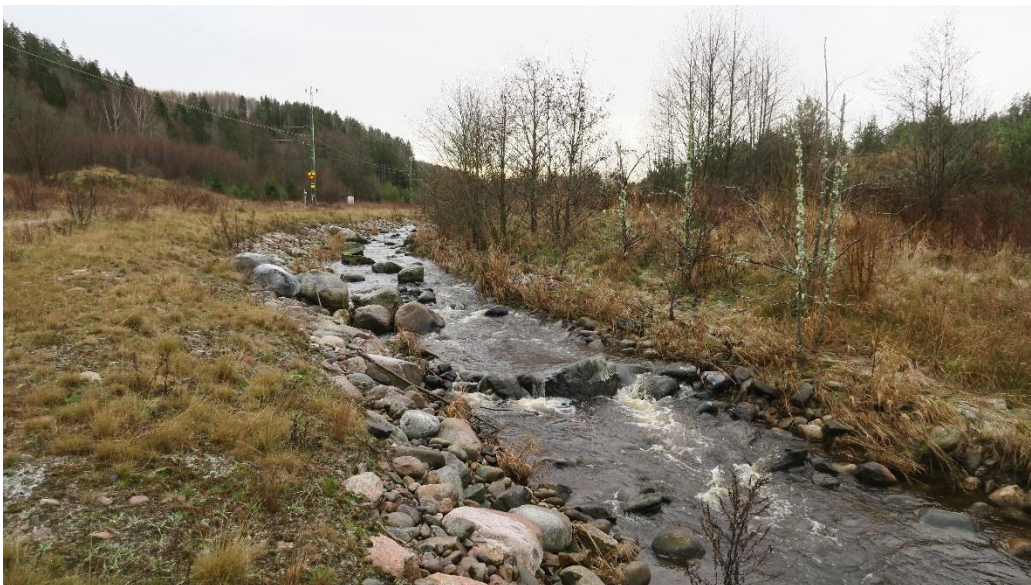
Bild 4. Sträcka som grävdes om efter skredet vid Småröd 2006 (T13). Sträckan har biotopvårdats med sten och block.
