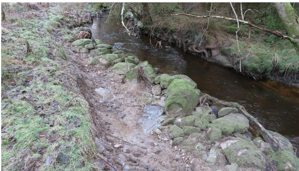
Bild 6. Sträcka T 31. Sträckan är rensad på större sten och block som lagts längs sidorna
