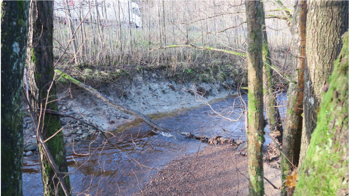
Bild 9. Skredärr i Taske å vid Fultaga (sträcka T 15).
