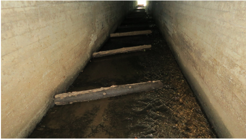
Bild 4. Inne i kulverten vid lågvattenföring 2018.
