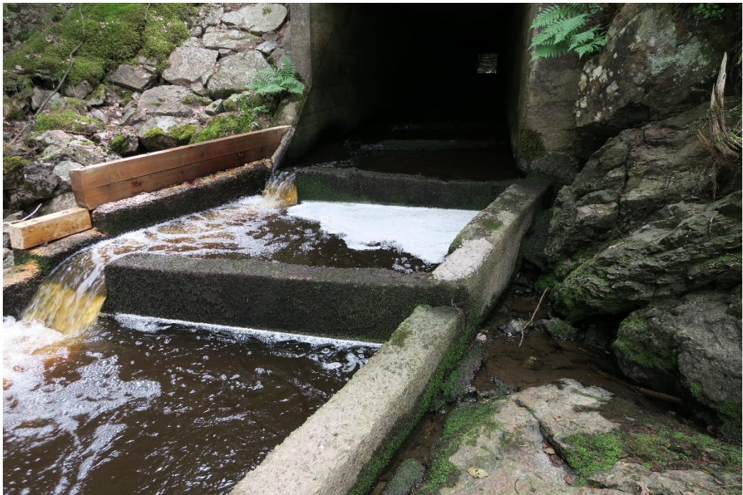
Bild 3. Bassängtrappan vid åtgärdsarbetena 2019.
