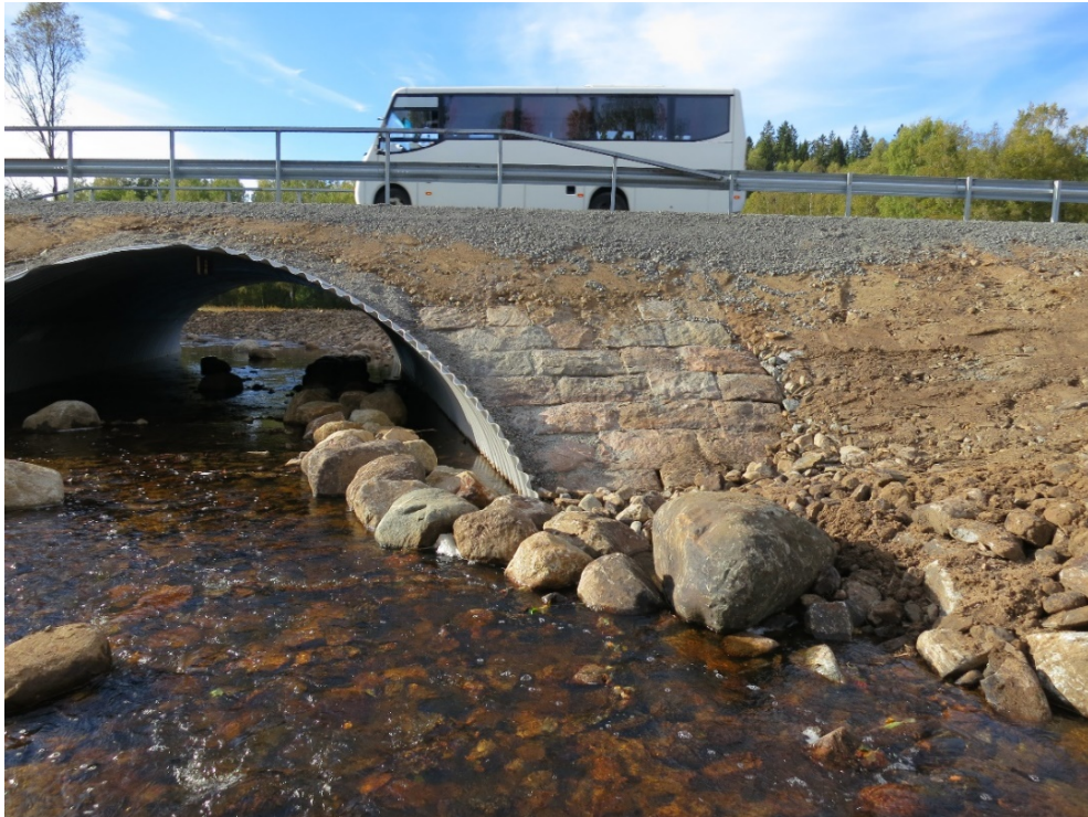
Bild 13. Valvbro (halvtrumma) med naturbotten i Nolån, Töllsjö 2013. Längs ena sidan har en landbrygga anlagts av natursten för att underlätta passagen för smådjur, ex. utter.
