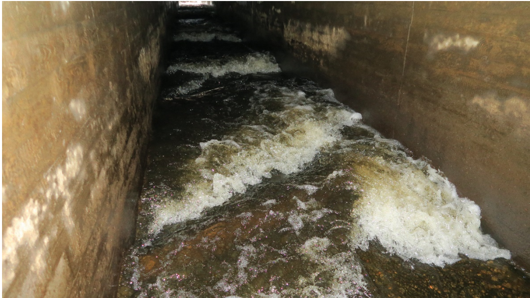
Bild 6. Inne i kulverten vid högvattenföring 2020.
