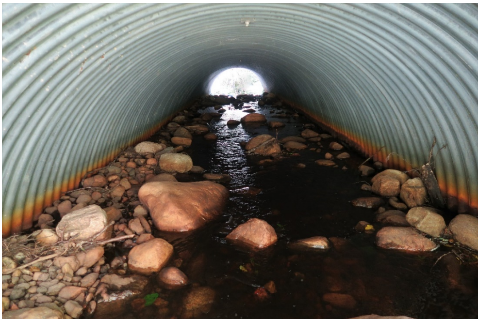
Bild 14. Valvbro (halvtrumma) i Åsanebäcken uppströms Hensbacka herrgård. Valvbågen anlades av Gullmarns vattenråd 2016.
