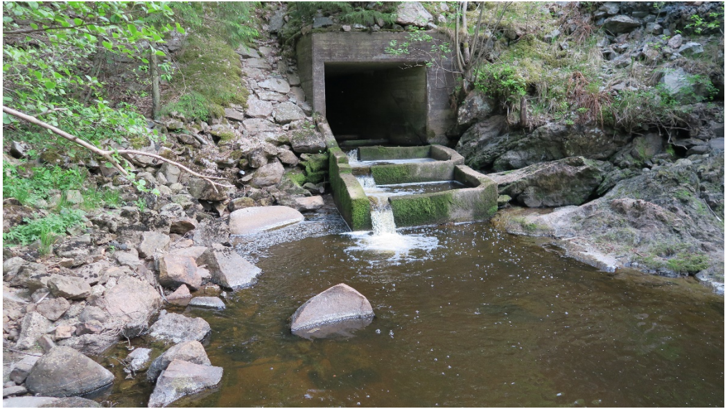
Bild 2. Kulvertens utlopp med bassängtrappan vid lågvattenföring.
