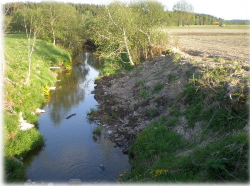
Bildtext Erosion vid Lerån
