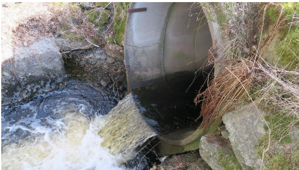
Bild 11. Hinder D5, vägtrumma under väg 2120.
