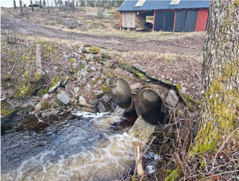
Bild 7. Hinder D2, dubbeltrumma under ägoväg.
