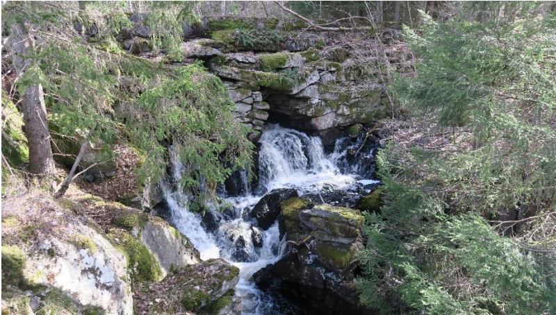
Bild 12. Hinder D6, damm.
