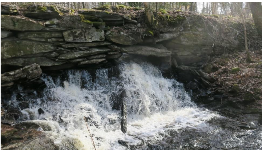
Bild 9. Hinder D3, damm.
