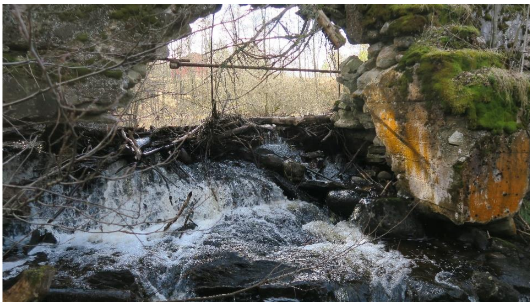
Bild 6. Hinder D1, damm.
