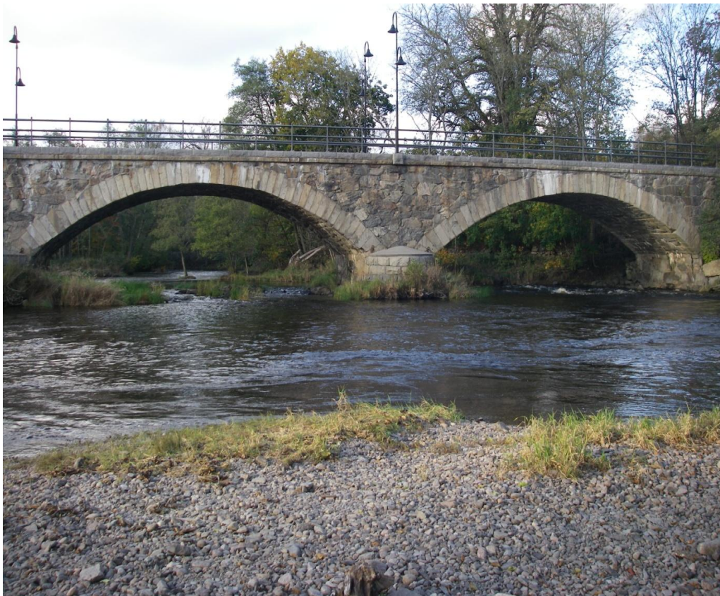
Bild 7 . Delsträcka 6 (nedströms bron) och 7 (uppströms bron).
