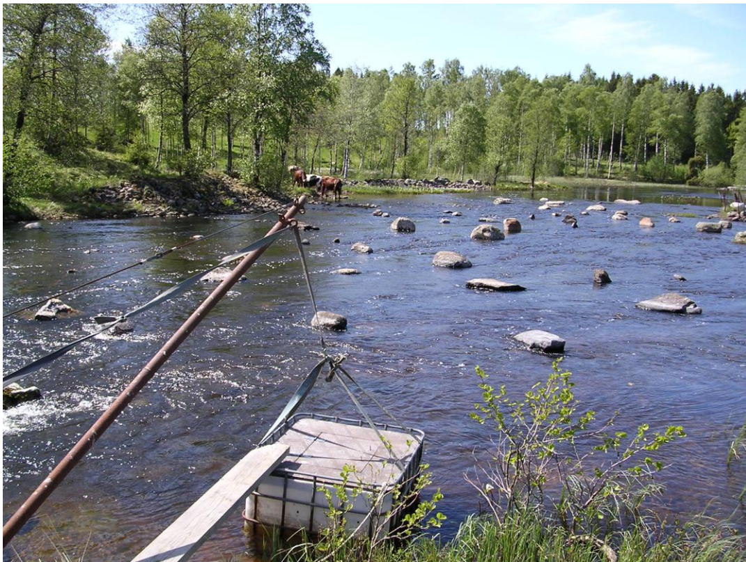
Bild 5. Kynneälv 2007. Exempel på åtgärdad flottled, notera den markanta skillnaden i strömbild där åtgärden upphört.
