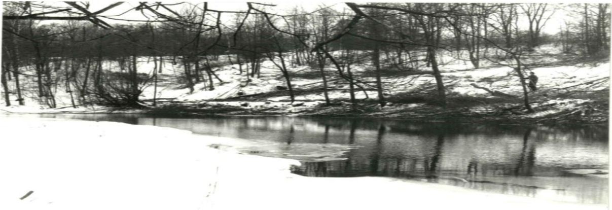
Bild 1. Före omgrävningen. Sträcka där Örekilsparken nu ligger
