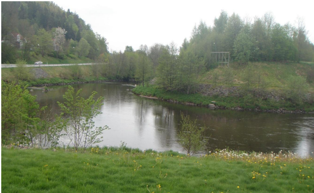
Bild 6 Delsträcka 5. Kviström. Notera erosionskydden och slänterna, samt att nytt älvmaterial avsatts nedanför erosionsmaterialet.
