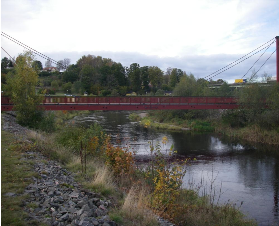
Bild 9. Delsträcka 9-10. Örekilsparken med gångbron. Notera erosionskydd.
