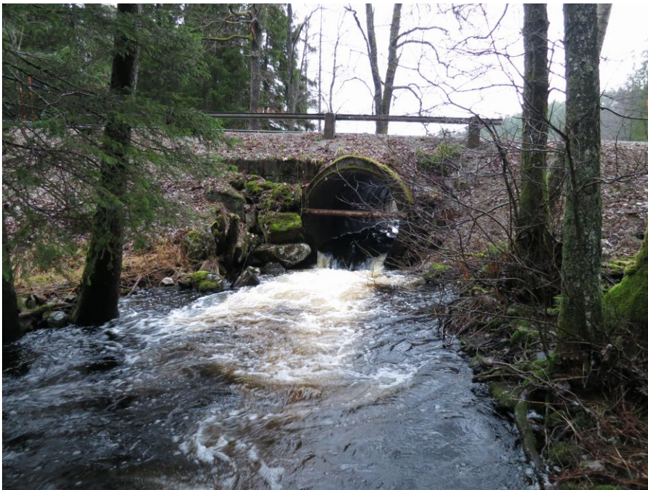
Bild 5. Vägtrumma vid Fällälven, lokalväg Pipevägen
