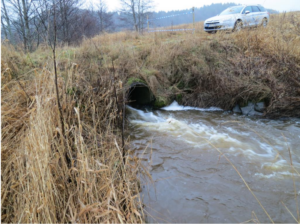
Bild 1. Vägtrumma lokalväg vid Håmule
