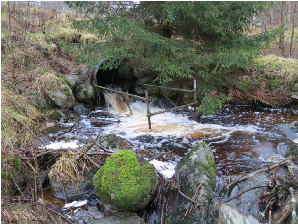
Bild 5. Vägtrumma lokalväg vid Hensbacka
