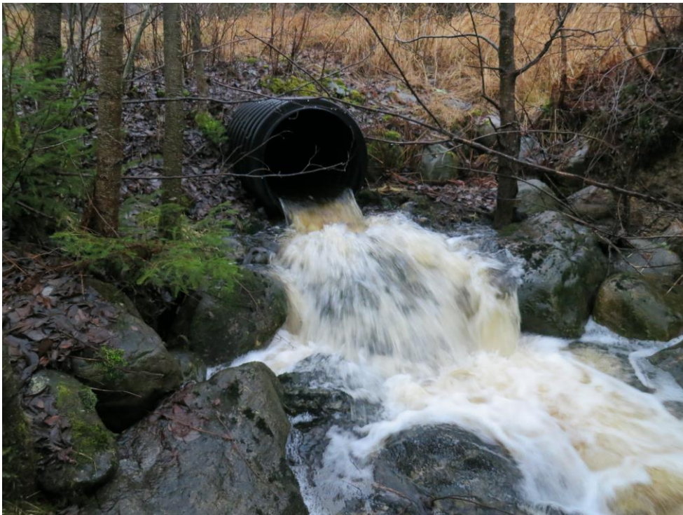
Bild 4. Vägtrumma vid mindre grusväg Stabberud
