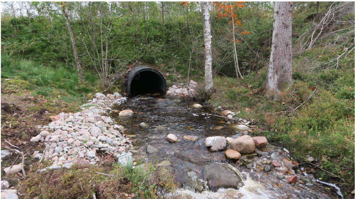
Bild 1. Vägtrumman O Dammhagen i Åsanebäcken efter åtgärd. 2017.
