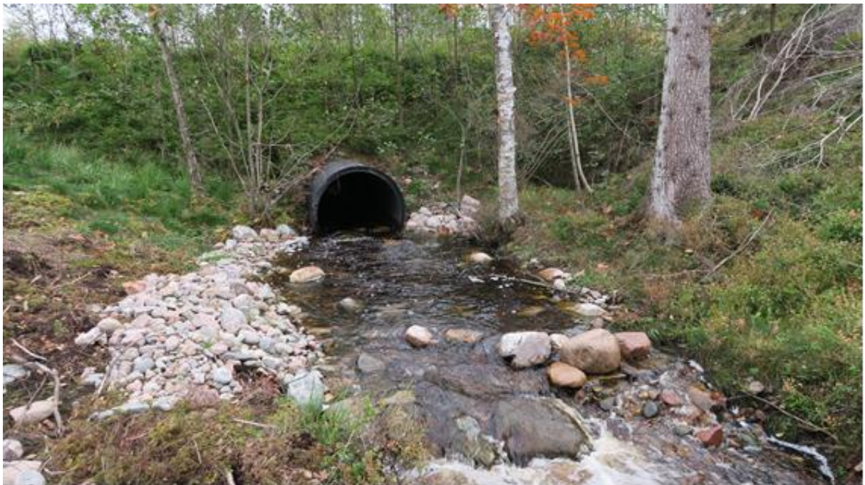
Bild 2. Vägtrumman nedströms lokal O Dammhagen i Åsanebäcken efter åtgärd 2017.
