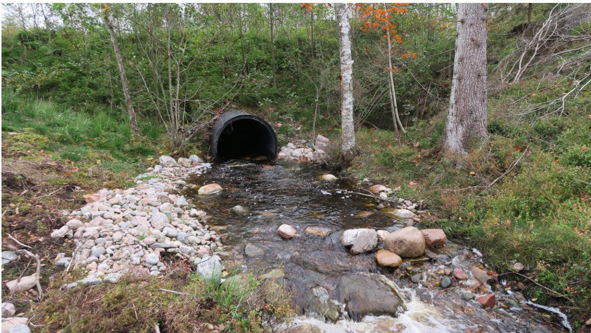
Bild 1. Vägtrumman O Dammhagen i Åsanebäcken efter åtgärd. 2017
