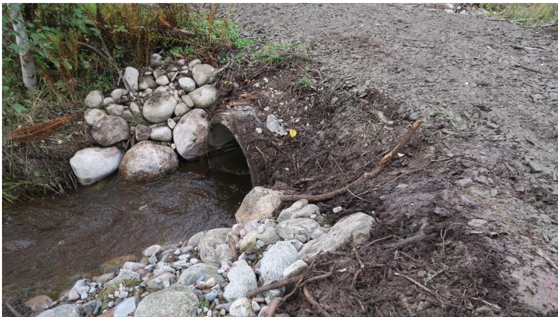
Bild 4. Vägtrumman vid Prästbol efter åtgärd 2020. Inloppet.
