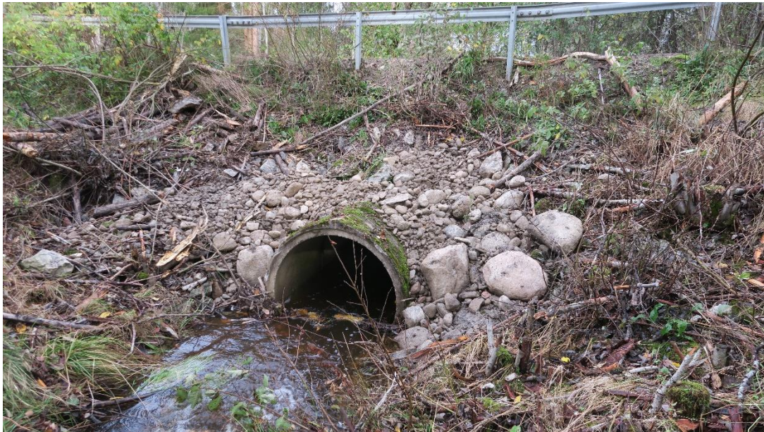
Bild 8. Vägtrumman vid Klockaredalen efter åtgärd. Inloppet.
