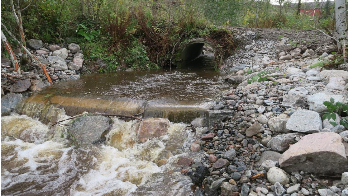
Bild 3. Vägtrumman vid Prästbol efter åtgärd 2020. Utloppet.
