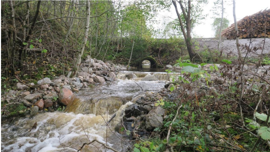
Bild 7. Vägtrumman vid Klockaredalen efter åtgärd. Utloppet.
