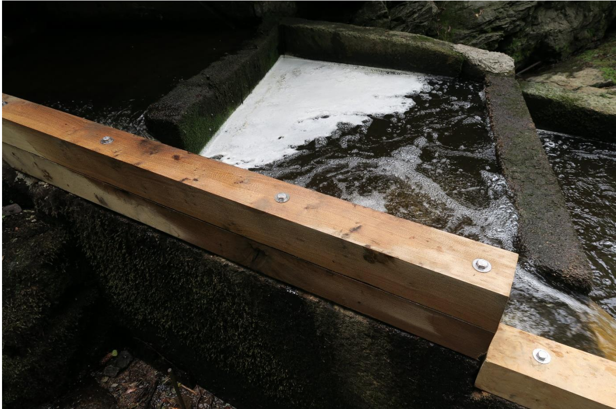
Bild 3. Fisktrappan i Taske å. Närbild på uppbyggd vägg.
