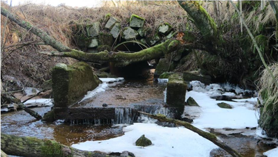
Bild 1. Vägtrumman vid Hästhagen. Betongkonstruktionen nedanför trumman härrör från den gamla vägbron.
