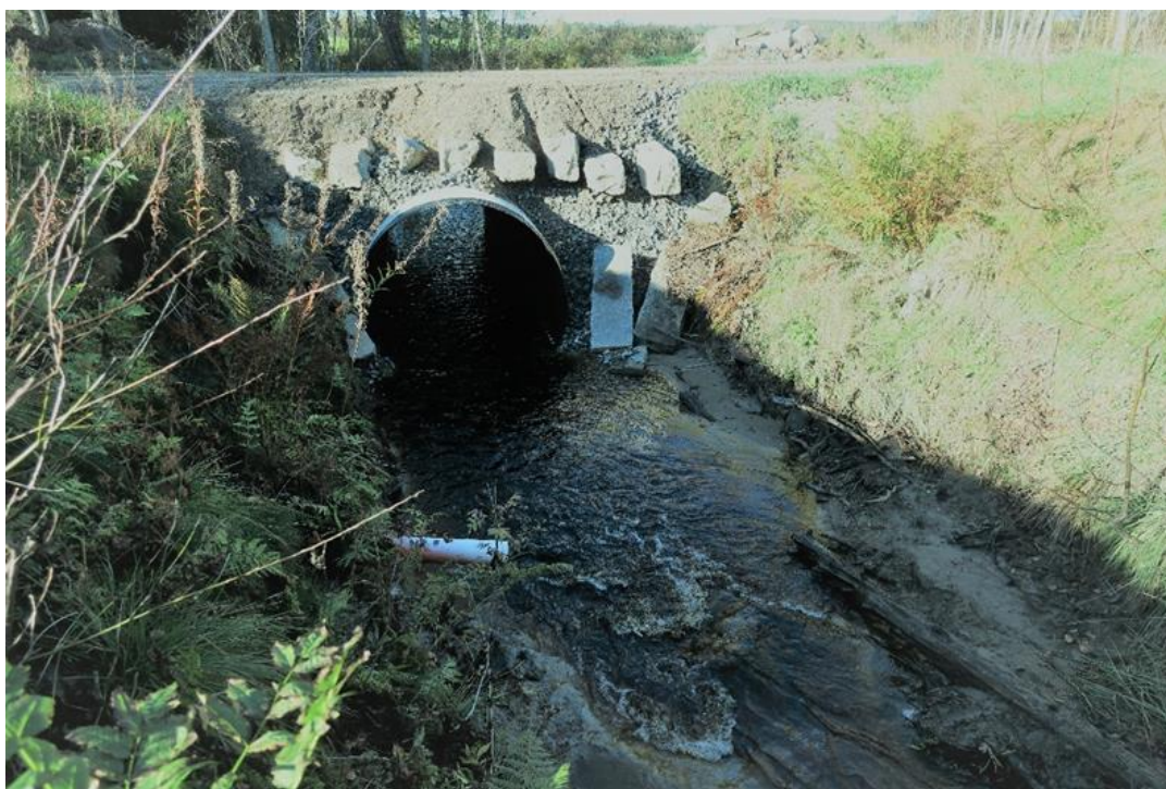
Bild 5. Under arbetet med byte av trumman. Uppströmssidan nästan färdig.
