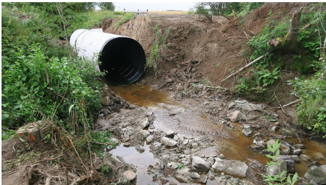
Bild 4. Under arbetet med byte av trumman. Nedströmssidan.
