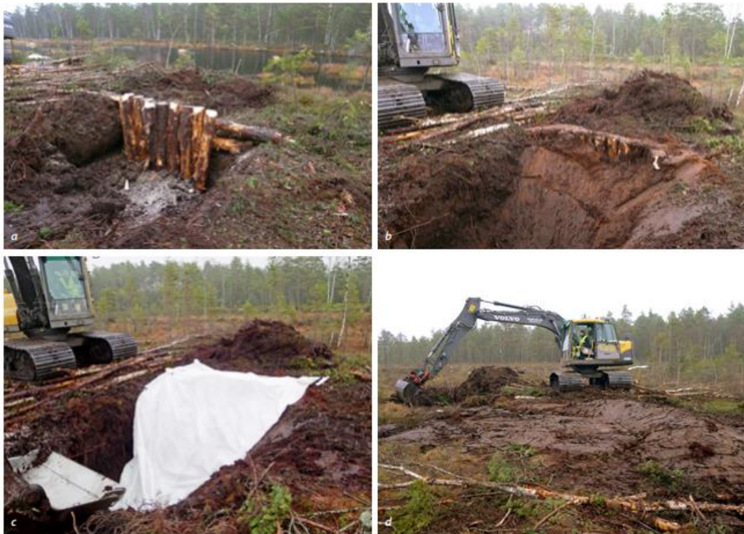
Figur 5. Exempel på bygge av dämme med en kärna av stående stockar (Foto: Kristoffer Paulsson, Länsstyrelsen i Jönköping län)
