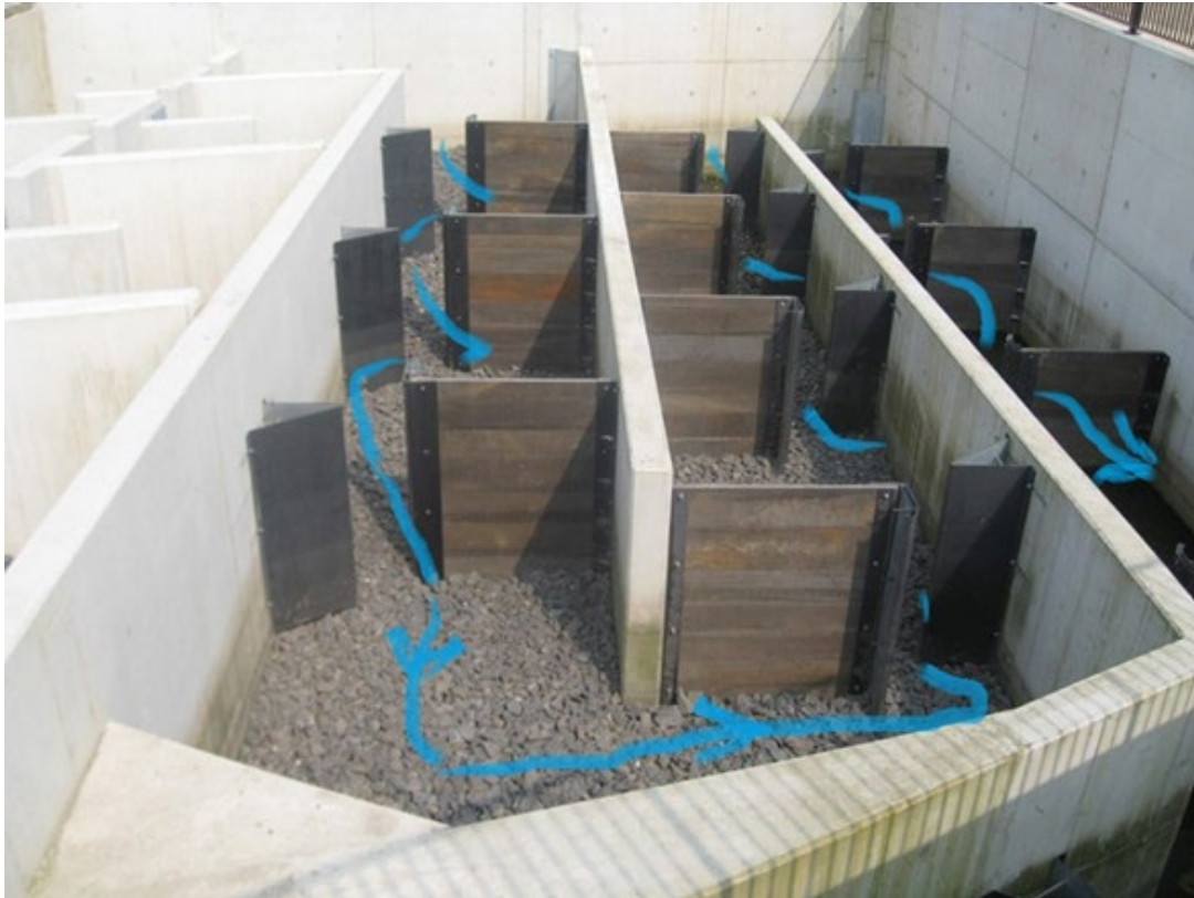
Bild 3. Gestaltning av slitsränna i Nederländerna. Den sicksackformade utformningen har gjorts för att kunna anpassa fiskvägen till platsen och erhålla en lämplig lutning. Bearbetat webbfoto.
