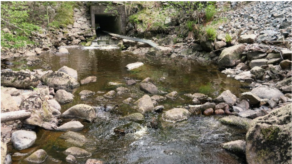
Bild 6. Bilden visar hur det är tänkt att se ut när åtgärderna är utförda (fotomontage). Vattenytans nivå nedan kulverten är i höjd med den anlagda stentröskeln och en utterspång har anlagts. Fotomontage av John Nelander.
