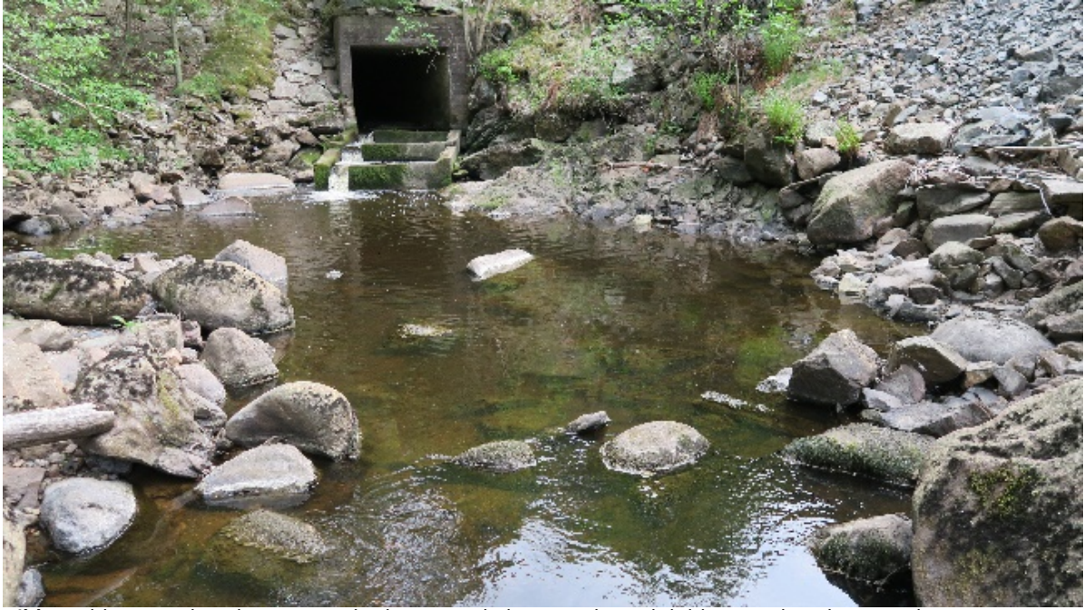
Bild 5. Bilden visar hur det ser ut vid utloppet av kulverten idag och bild 6 visar hur det är tänkt att se ut när åtgärderna är klara.
