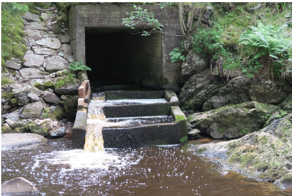
Bild 1. Befintligt utseende på kulvertens utlopp med kammatrappan (2019-07-09).
